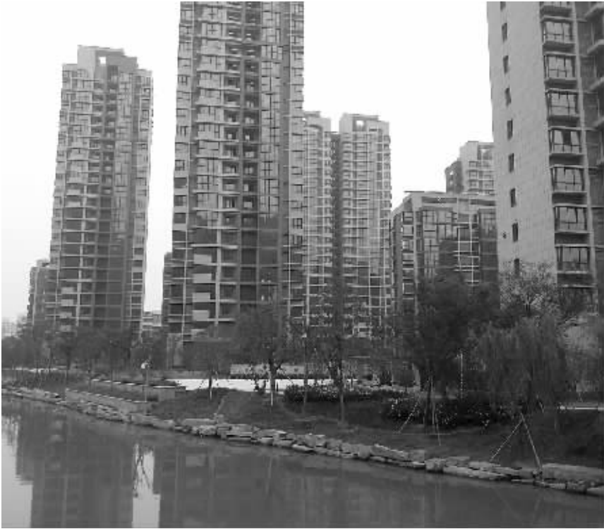
联丰村安置房项目丰馨苑小区一瞥。
